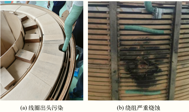
图3 A 相高压绕组解体情况
